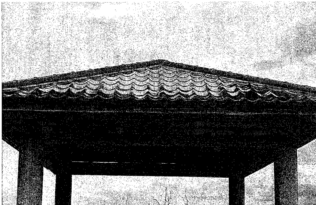
霍亂紀念碑 屋頂腐蝕
