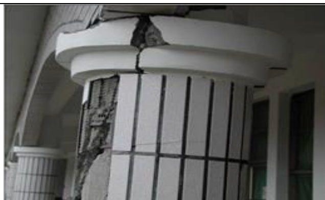
2003 年 12 月 10 日地震:博愛國小走廊圓柱發生剪力破壞(洗手台造成該柱較短,約一百公尺長之走廊僅此柱破壞)。
