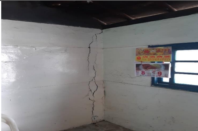
0918 地震災害民宅房屋龜裂及鋼筋裸露
