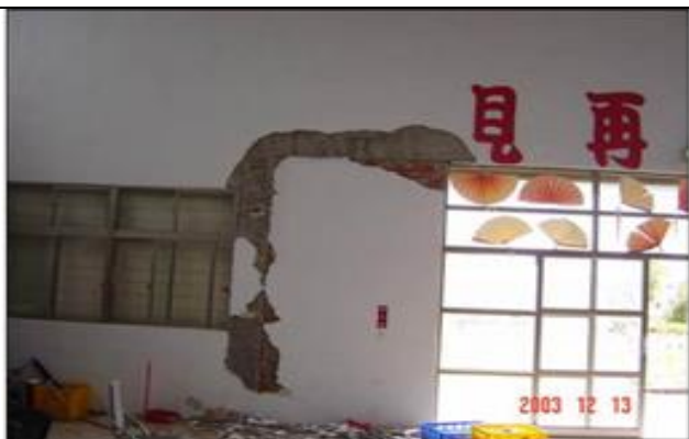
2003 年 12 月 10 日地震:忠孝國小禮堂入口旁之磚牆震裂(與 RC 柱之界面處)。
