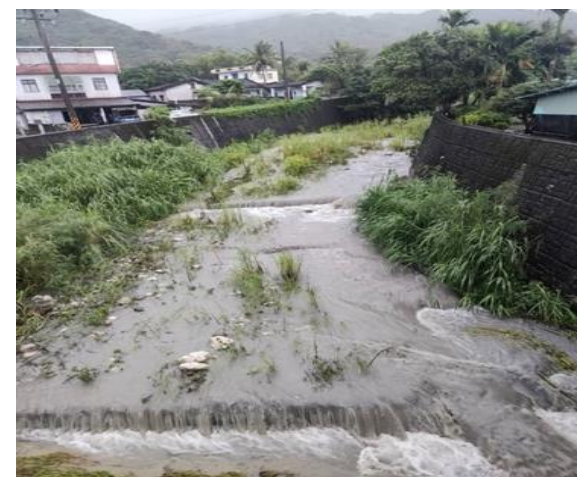
DF156 土石流潛勢溪流現況，地標信義里知名橋，固床工方式防範土石流
