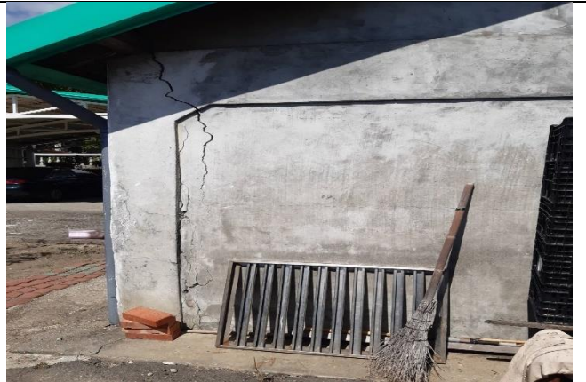
0918 地震災害民宅房屋龜裂及鋼筋裸露
